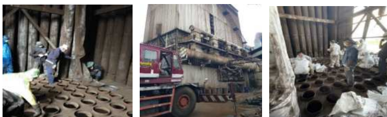
ภาพที่ 2.25 การเปลี่ยนอุ้งกรงจากระบบบำบัดอากาศ
