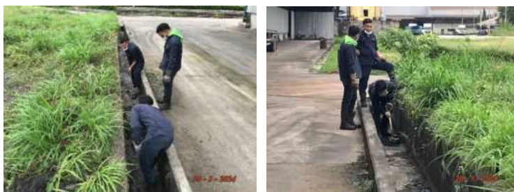
ภาพที่ 2.24 การลอกท่อระบายน้ำภายในโครงการ
