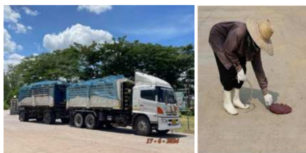
ภาพที่ 2.4 การปิดคลุมรถบรรทุกและการเก็บกวาดวัสดุที่ตกหล่น
